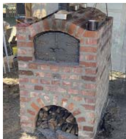
Dieser Buschbackofen wurde aus Ziegeln eines maroden Gartenhäuschens gemauert.
